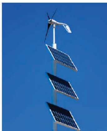
Figura: Sistema Híbrido 2 – Eólica-solar
